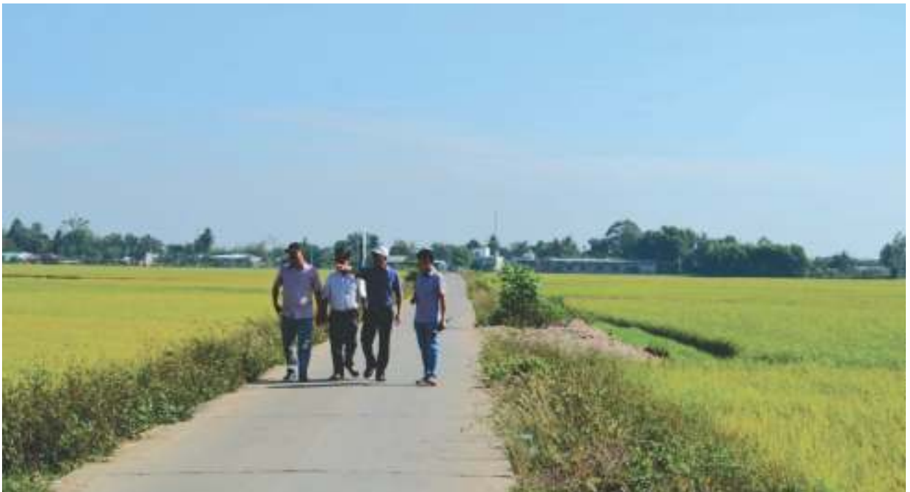
Tuyến đường Đò được đầu tư bằng nguồn xã hội hóa
